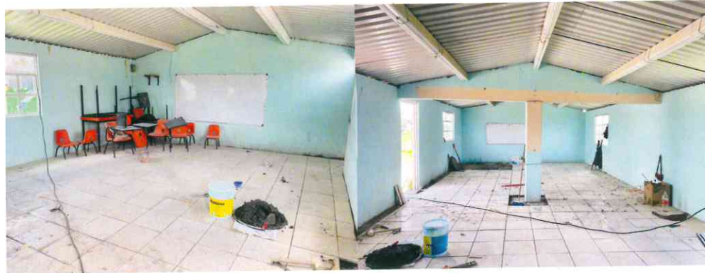
Salones de las escuelas con su losa.
