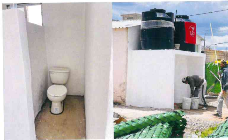
Trabajos de mejoramiento de instalaciones sanitarias en las escuelas.
