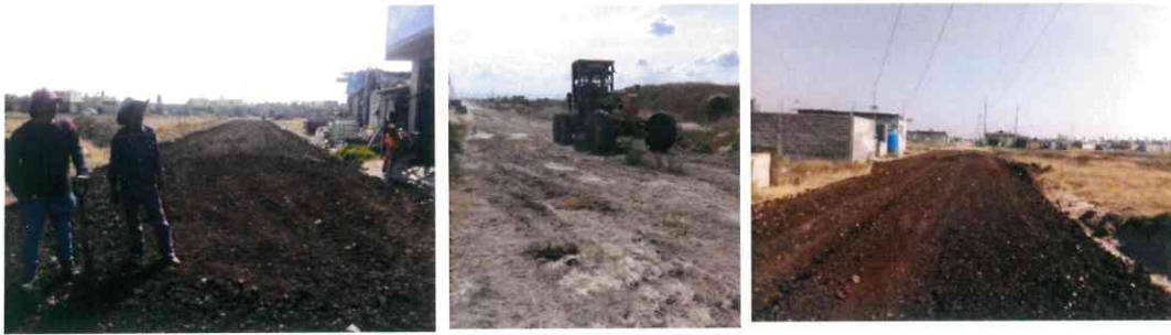
Maquinaria realizando aplanado de calles. También se rellenaron con tepetate.
