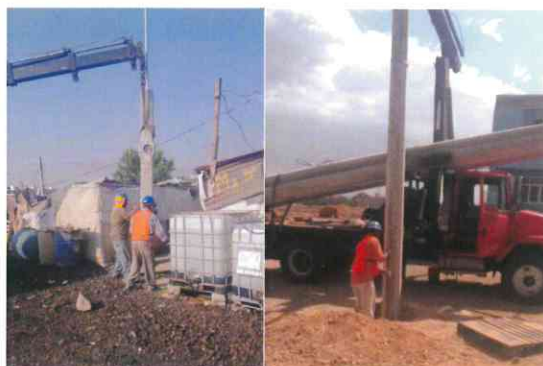
Trabajos de electrificación en la colonia José Humberto.
