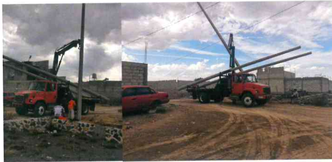
Trabajos de electrificación en la colonia Polo Norte.
