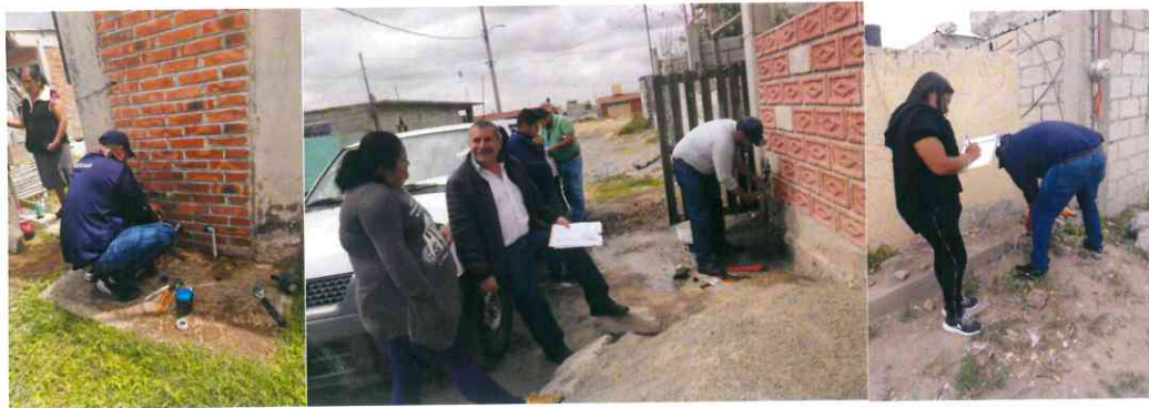
Personal de la CAAMTH cambiando medidores en la “Antorcha”.
