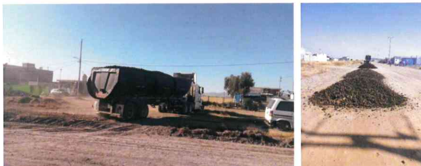
Fotografías.- Maquinaria realizando aplanado de calles. También se rellenaron con tepetate.
