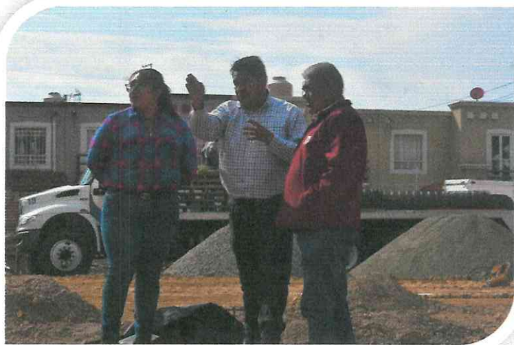
Recorrido en obras
